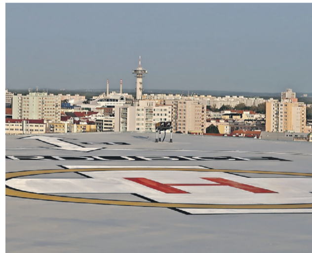
Nový heliport na střeše centrálního příjmu. Foto KÚ Pardubického kraje
